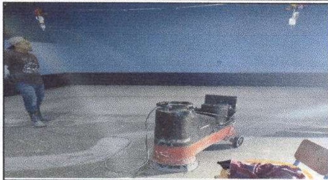
Foto 7: Mantenimiento de piso de granito ( pulido y lustrado)
