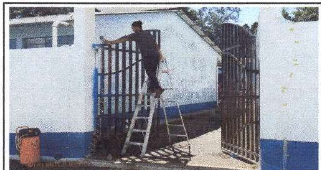
Foto 10: Mantenimiento a portón de metal
