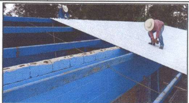
Foto 2: Sustitución de elementos de fijación
