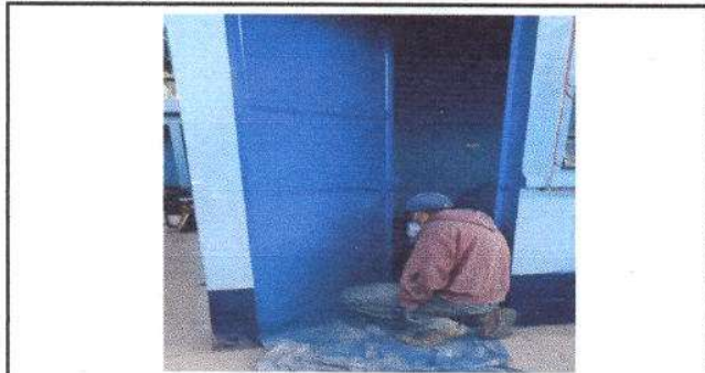
Foto 9: Mantenimiento de estructura ( lijado, cambio de tubo, cepillo sujeciones, aplicación de pintura)
