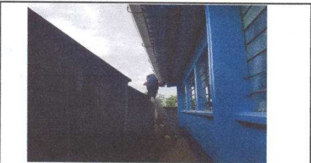
Foto 5: Sustitución de canal de PVC y accesorios
