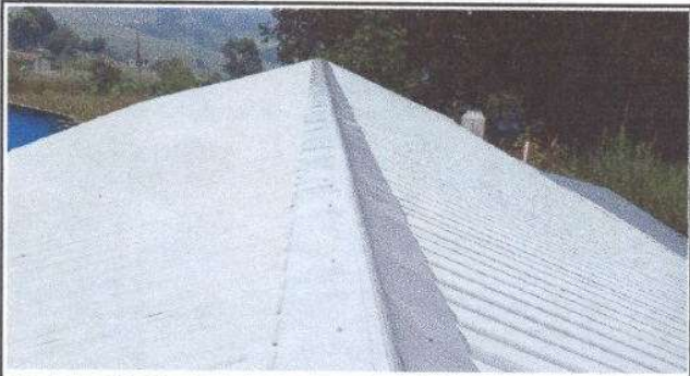
Foto 3: Sustitución de capote de lámina
