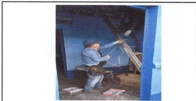
Foto 11: Reparación del sistema eléctrico.
