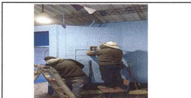
Foto 12: Reparación del sistema eléctrico.
