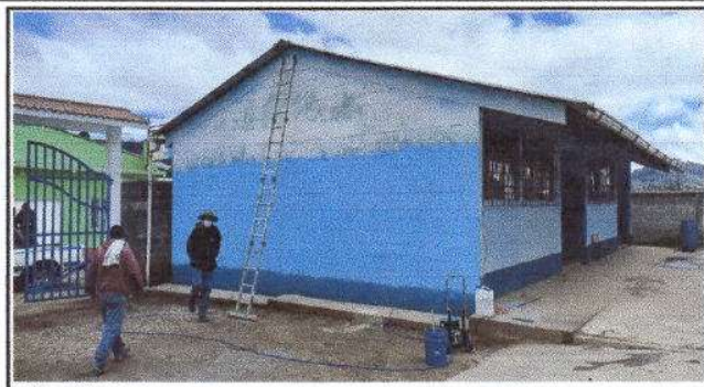
Foto 8: Pintura en muros exteriores e interiores
