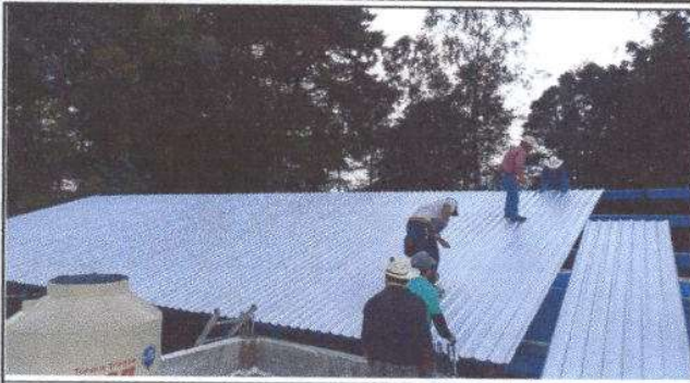
Foto1: Sustitución de lámina acanalada por lámina troquelada aluzinc calibre 26
