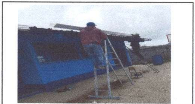
Foto 4: Sustitución de bajadas de agua pluvial tubo pvc 3" y accesorios
